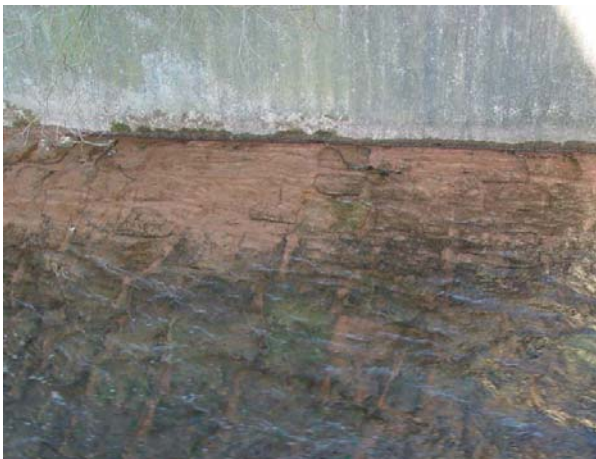
Abbildung 15: Technolithal 2 (Geschlossener Verbau)
